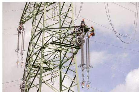
An den Isolatoren werden später die Leiterseile befestigt, die den Strom transportieren.
