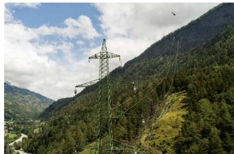
Der Helikopter zieht das Vorseil an, an welchem anschliessend die Leiterseile hochgezogen werden.
