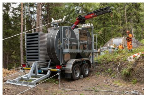
Die Leiterseile aus Aldrey (Aluminiumlegierung) sind auf einer Kabelbobine aufgerollt und werden mit einer Zugmaschine eingezogen.
