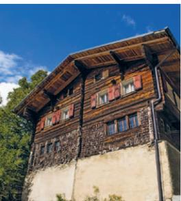
Der älteste Hausteil (Keller und erstes Stockwerk) wurde laut dendrochronologischer Untersuchung 1389 erbaut, eine Inschrift auf dem Deckenbalken bezeugt zudem einen Umbau im 16. Jh. 1738 entstand darüber ein neues, traufseitig leicht vorkragendes Obergeschoss mit ursprünglich zwei vertikal getrennten Woh-
